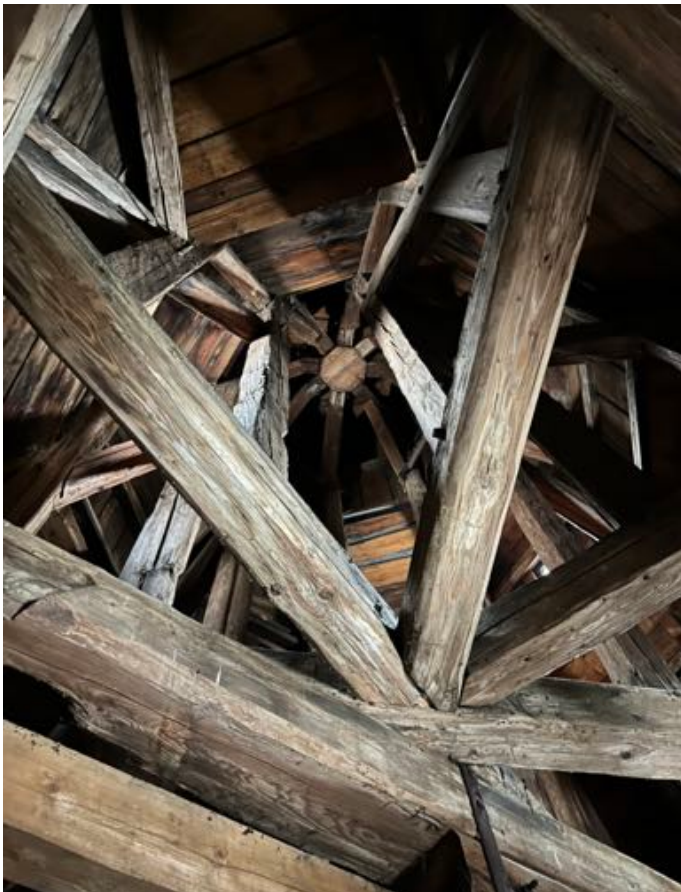
Fot. 68. Kościół pw. św. Jadwigi Śląskiej w Karpnikach. Wnętrze wieży, widok z poziomu górnych okien — biforium ku górze na krzyżakowe konstrukcje belkowe hełmu wieży. Fot. Styczeń 2023 r.
