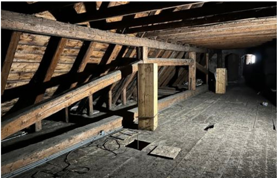
Fot. 52. Kościół pw. św. Jadwigi Śląskiej w Karpnikach. Więźba dachowa, strona zachodnia poddasza na poziomie pierwszego piętra konstrukcji więźby, widoczne krokwie oraz miecze stopowe wiązarów po stronie południowej oraz wtórne usztywnienie konstrukcji w formie ściany ryglowej (przypuszczalnie po wymianie pokrycia z gontu na łupkę nastąpiło odkształcenie konstrukcji, tym samym usztywnienie to zostało odciążone). Fot. Styczeń 2023 r.
