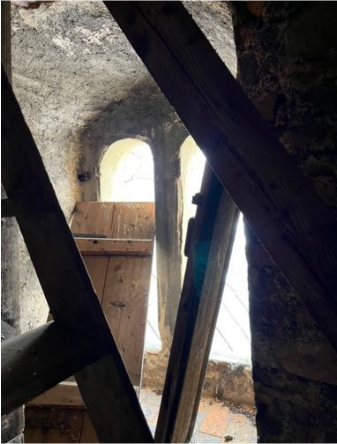
Fot. 69. Kościół pw. św. Jadwigi Śląskiej w Karpnikach. Wnętrze wieży, biforium (podwójne okno arkadowe). Fot. Styczeń 2023 r.
