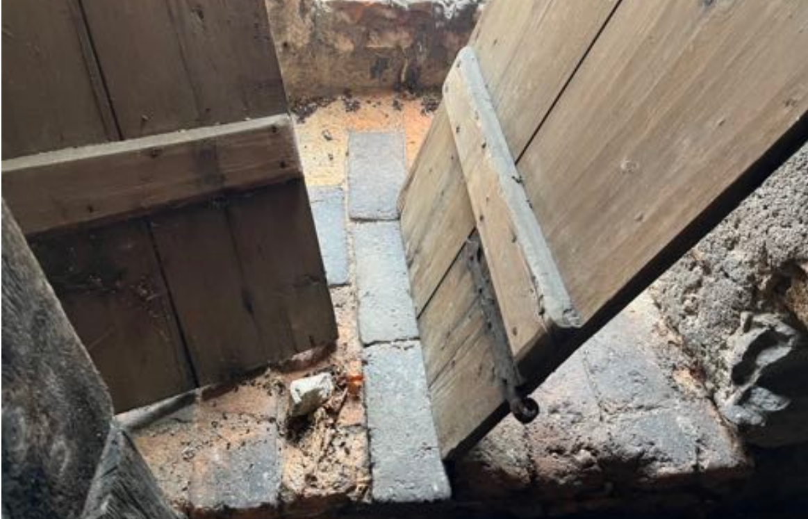
Fot. 70. Kościół pw. św. Jadwigi Śląskiej w Karpnikach. Wnętrze wieży, ceglany parapet biforium i fragmenty okiennic. Fot. Styczeń 2023 r.
