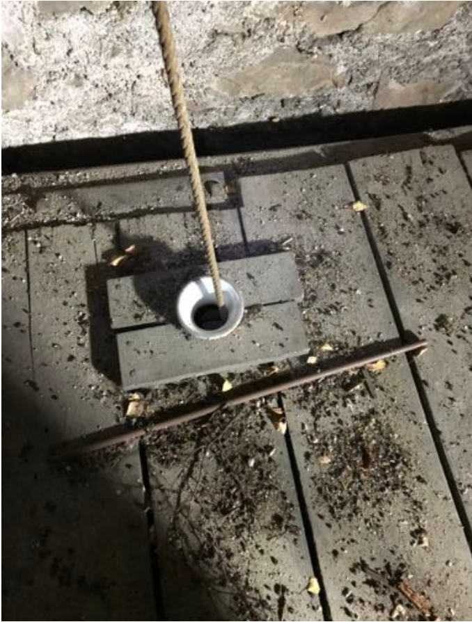
Fot. 71. Kościół pw. św. Jadwigi Śląskiej w Karpnikach. Wnętrze wieży, porcelanowe tulejki osłaniające przejście lin dzwonu przez podłogę. Fot. Styczeń 2023 r.
