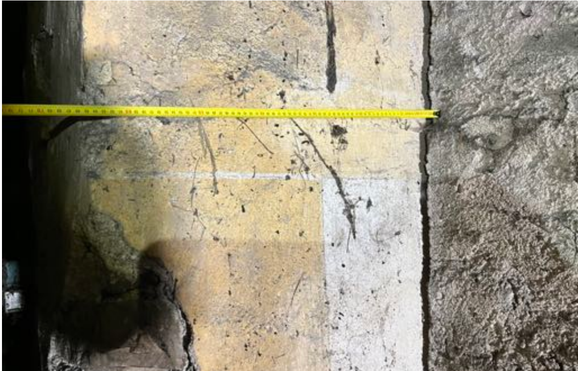
Fot. 31. Kościół pw. św. Jadwigi Śląskiej w Karpnikach. Poddasze nad nawą kościoła, północno-wschodni narożnik wieży, fragment zachowanej pierwotnej aranżacji architektonicznej elewacji wieży w formie malowanych na tynku ciosów żółtego piaskowca i białych spoin. Fot. Styczeń 2023 r.
