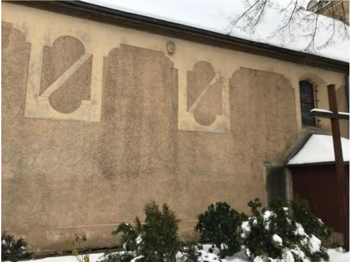
Fot. 3. Kościół pw. św. Jadwigi Śląskiej w Karpnikach. Elewacja północna w części wschodniej, widoczna wmurowana kamienna rzeźba głowy pod gzymsem oraz epitafium obok kruchty. Fot. Styczeń 2023 r.
