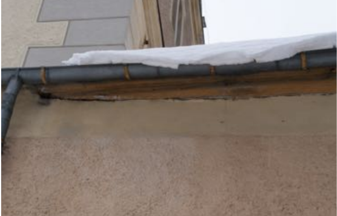
Fot. 45. Kościół pw. św. Jadwigi Śląskiej w Karpnikach. Elewacja południowa w części zachodniej, na styku z wieżą, widoczny fragment gzymsu. Fot. Styczeń 2023 r.
