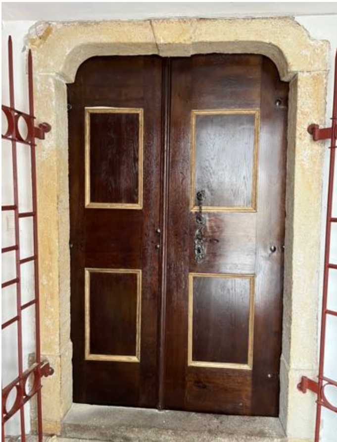
Fot.10. Kościół pw. św. Jadwigi Śląskiej w Karpnikach. Drewniane drzwi wejściowe i renesansowy portal kamienny (piaskowiec) wewnątrz kruchty (północne wejście do kościoła). Fot. Styczeń 2023 r.
