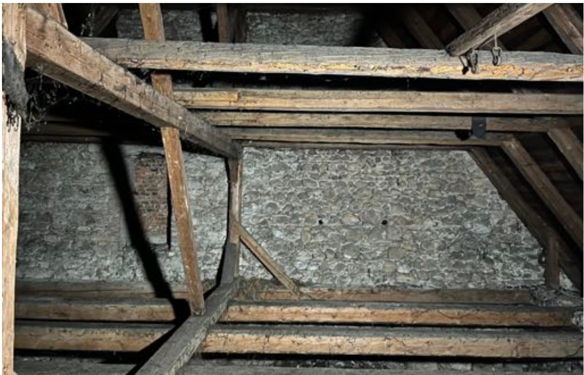
Fot. 54. Kościół pw. św. Jadwigi Śląskiej w Karpnikach. Więźba dachowa, widok na ścianę wschodnią kościoła na poziomie pierwszego piętra konstrukcji, widoczna podwalina ramy storczykowej, wraz ze storczykami i mieczami stopowymi, belki wiązarowe nad prezbiterium i zakrystią, jętki powyżej oraz zamurowany otwór okienny nad zakrystią. Fot. Styczeń 2023 r.
