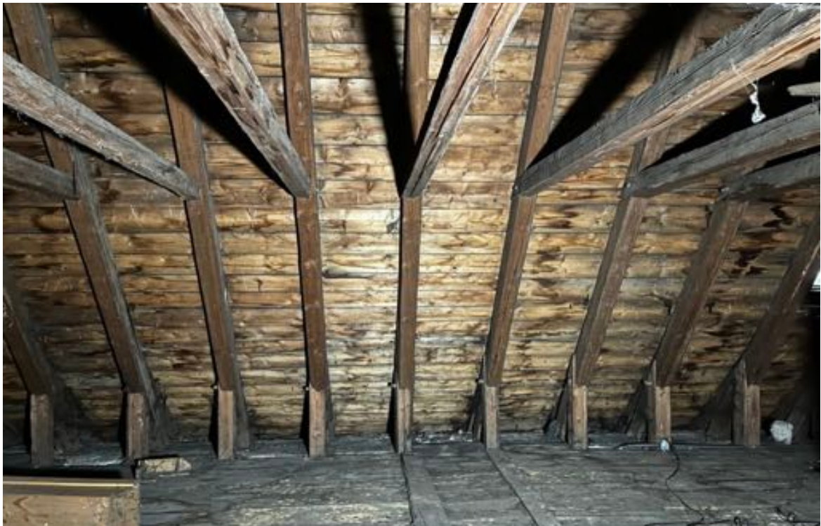
Fot. 50. Kościół pw. św. Jadwigi Śląskiej w Karpnikach. Więżba dachowa, krokwie, jętki i miecze stopowe wiązarów po stronie północnej, widoczne ślady żerowania kołatka w postaci mączki drzewnej. Fot. Styczeń 2023 r.
