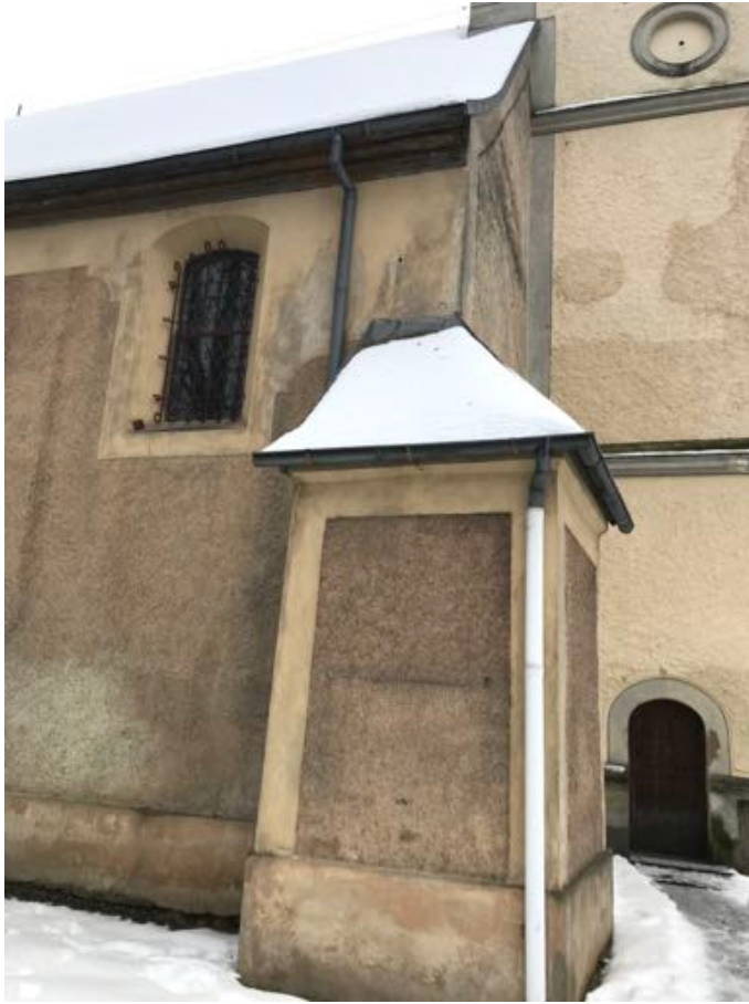
Fot. 11. Kościół pw. św. Jadwigi Śląskiej w Karpnikach. Przypora w północno-zachodnim narożniku budynku. Fot. Styczeń 2023 r.
