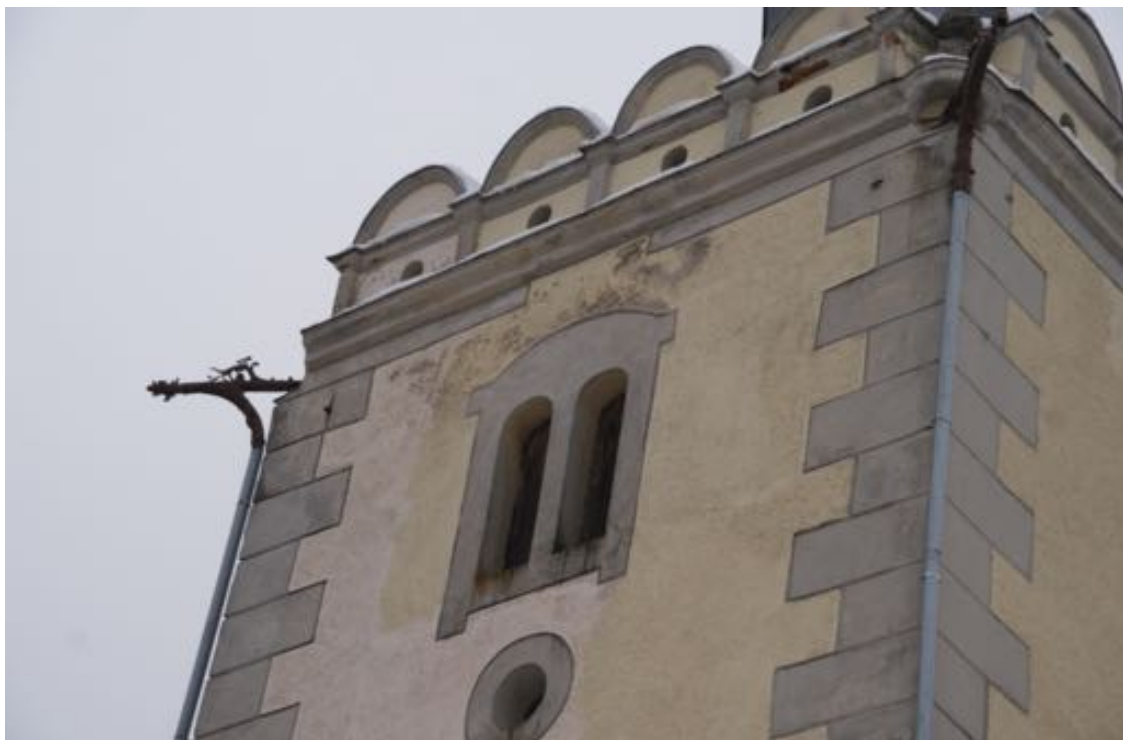
Fot. 20. Kościół pw. św. Jadwigi Śląskiej w Karpnikach. Elewacja zachodnia wieży kościoła, widoczne biforium na najwyższej kondygnacji oraz renesansowa attyka (indywidualny numer rejestru nr 472/12). Fot. Styczeń 2023 r.
