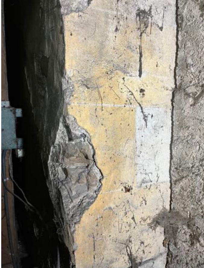
Fot. 30. Kościół pw. św. Jadwigi Śląskiej w Karpnikach. Poddasze nad nawą kościoła, północno-wschodni narożnik wieży, fragment zachowanej pierwotnej aranżacji architektonicznej elewacji wieży w formie malowanych na tynku ciosów żółtego piaskowca i białych spoin, widoczny fragmenty kamiennego muru wieży w miejscu ubytku warstwy tynkarskiej. Fot. Styczeń 2023 r.
