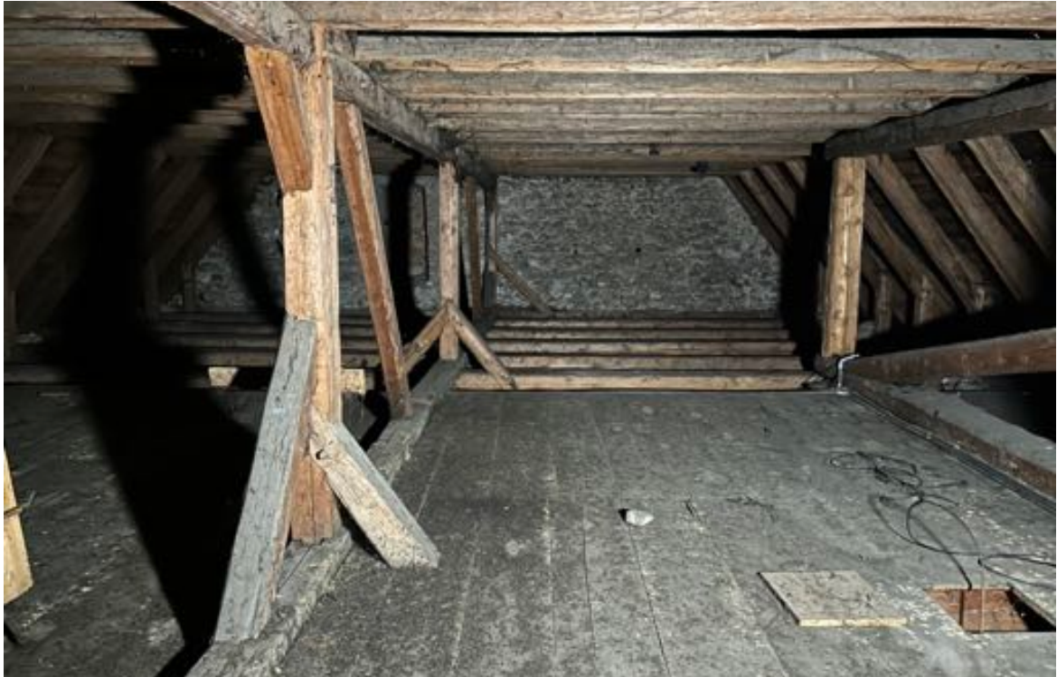
Fot. 51. Kościół pw. św. Jadwigi Śląskiej w Karpnikach. Więźba dachowa, widok na ścianę wschodnią kościoła na poziomie pierwszego piętra konstrukcji, widoczna podwalina ramy storczykowej, wraz ze storczykami i mieczami stopowymi, deskowa podłoga poddasza, belki wiązarowe nad prezbiterium i zakrystią oraz jętki powyżej. Fot. Styczeń 2023 r.
