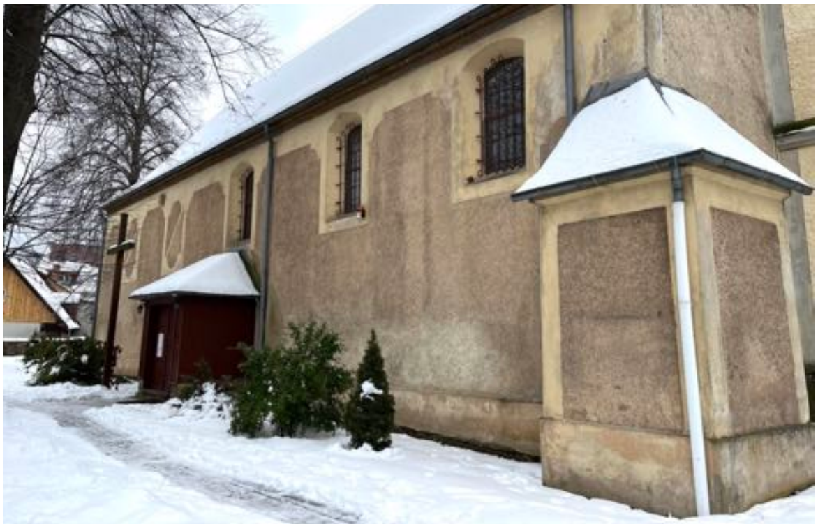
Fot. 2. Kościół pw. św. Jadwigi Śląskiej w Karpnikach. Elewacja północna. Fot. Styczeń 2023 r.
