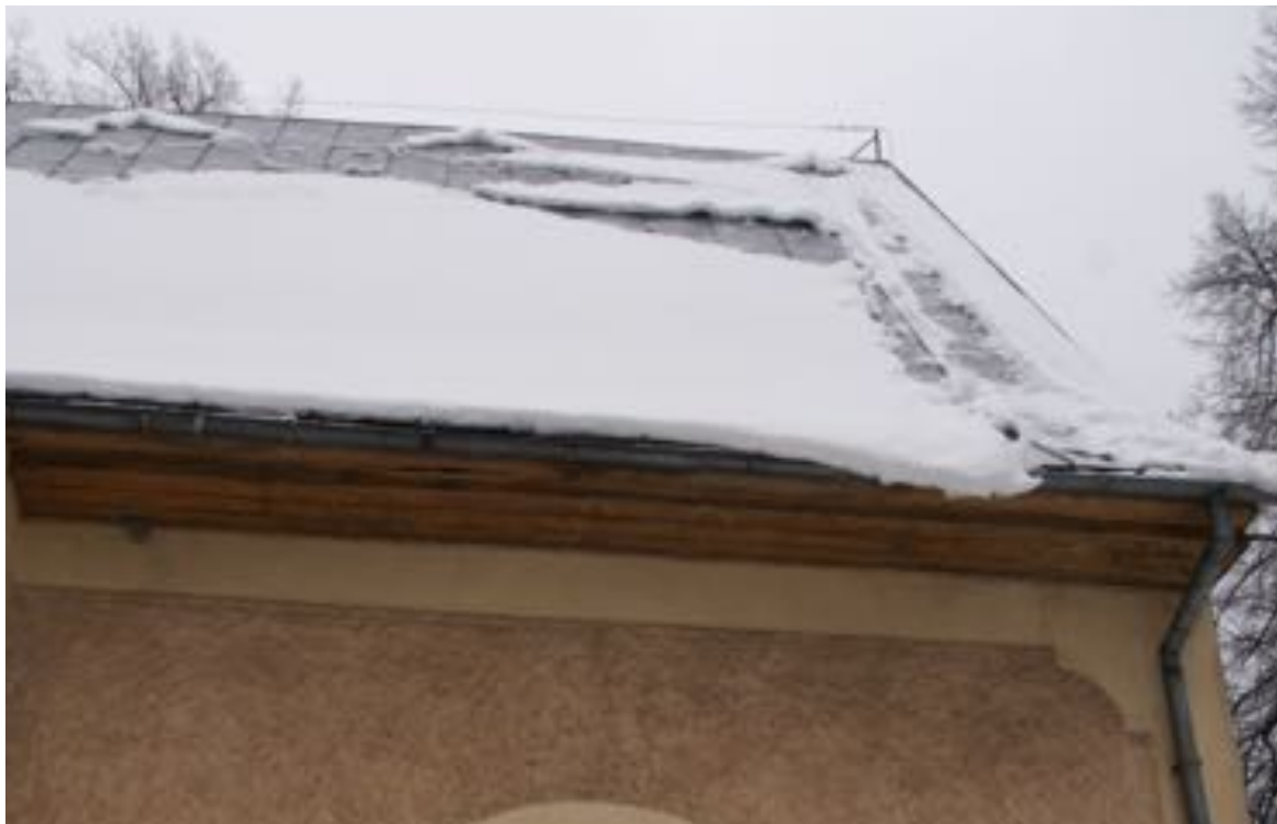
Fot. 42. Kościół pw. św. Jadwigi Śląskiej w Karpnikach. Dach nad prezbiterium. Fot. Styczeń 2023 r.
