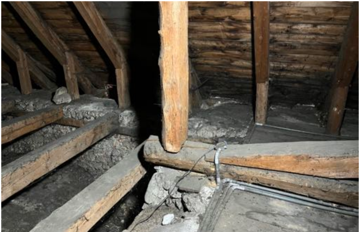
Fot. 53. Kościół pw. św. Jadwigi Śląskiej w Karpnikach. Więźba dachowa, strona południowa na poziomie pierwszego piętra konstrukcji, miejsce połączenia prezbiterium i nawy, widoczna od góry ściana łuku tęczowego oraz konstrukcja kamienna ścian obwodowych, oparcie belek wiązarowych na namurnicy, krokwie strony południowej dachu oraz słup wtórej konstrukcji ramowej. Fot. Styczeń 2023 r.
