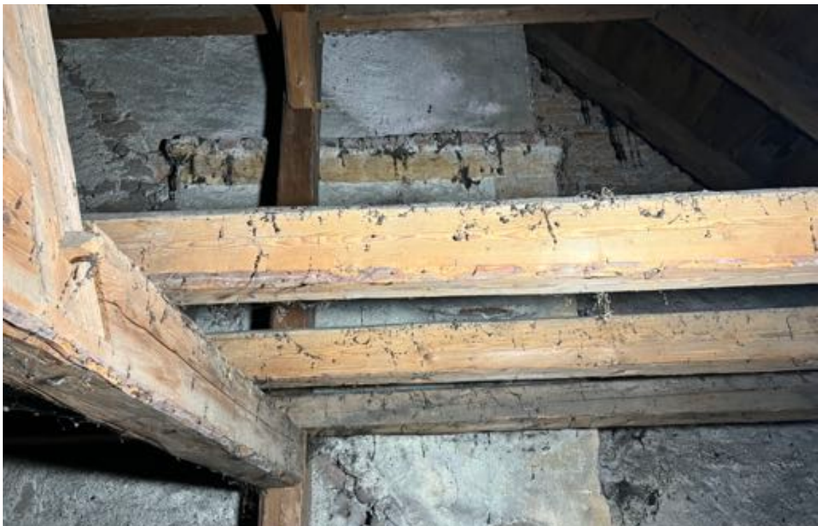
Fot. 26. Kościół pw. św. Jadwigi Śląskiej w Karpnikach. Poddasze nad nawą kościoła, ślady pierwotnego szczytu zachodniego na ścianie wschodniej wieży, powyżej jętek więźby dachowej widoczny fragment pierwotnie ekspozowanego na elewacji gzymsu wieży. Fot. Styczeń 2023 r.
