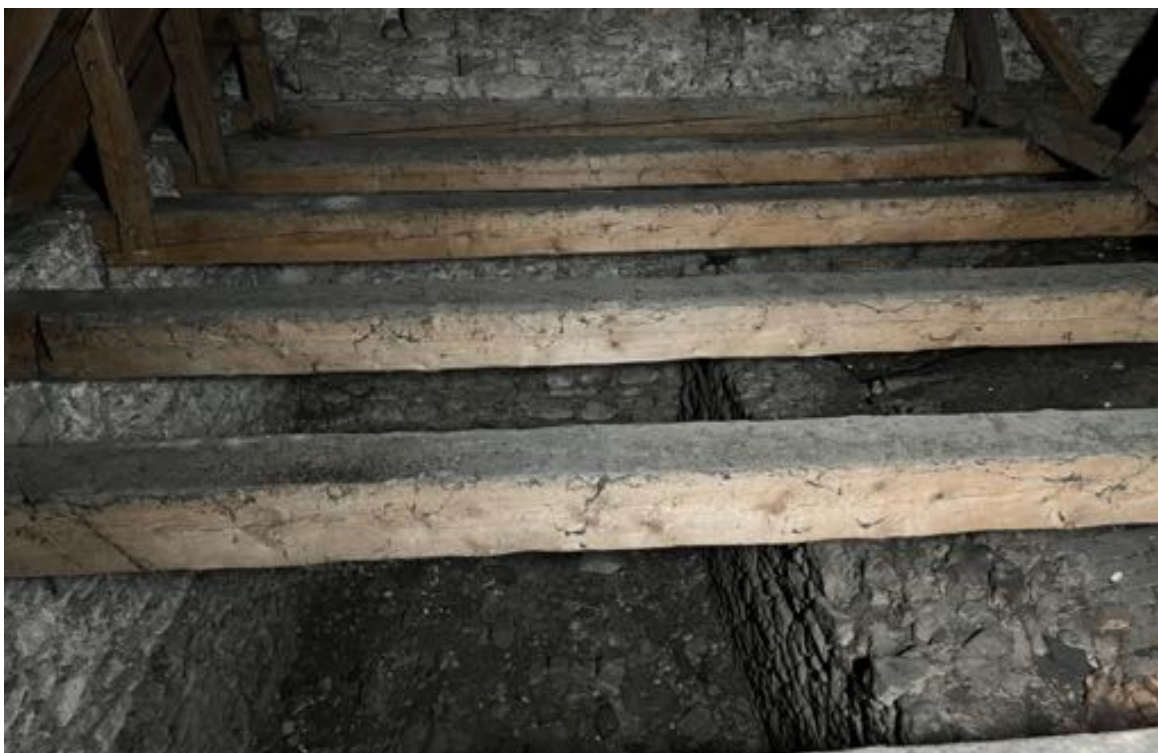
Fot. 55. Kościół pw. św. Jadwigi Śląskiej w Karpnikach. Więźba dachowa, widoczne belki wiązarowe nad zakrystią oraz kamienna konstrukcja ściany oddzielającej zakrystię od prezbiterium. Fot. Styczeń 2023 r.
