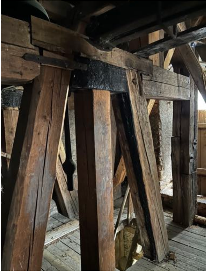
Fot. 67. Kościół pw. św. Jadwigi Śląskiej w Karpnikach. Wnętrze wieży, widoczna konstrukcja zawieszenia dzwonów na poziomie górnych okien — biforium. Fot. Styczeń 2023 r.
