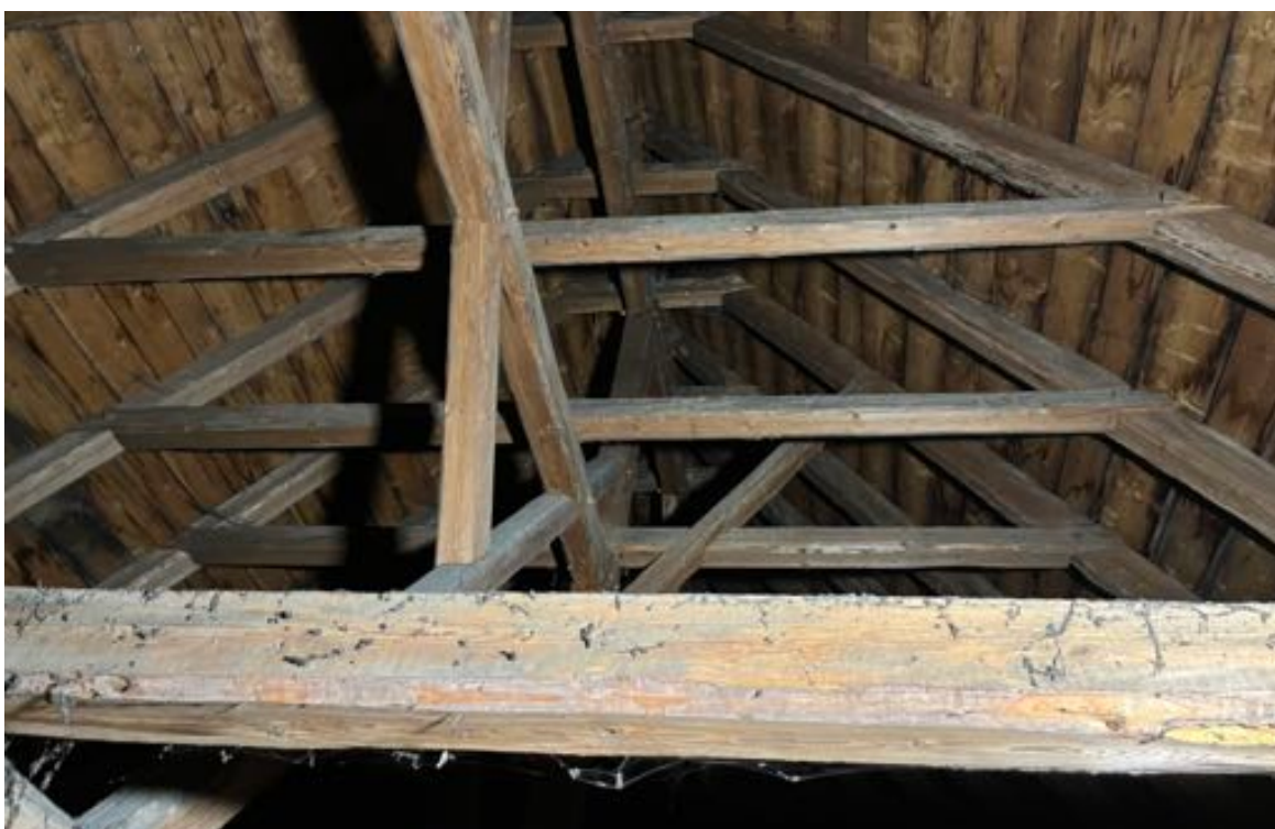
Fot. 56. Kościół pw. św. Jadwigi Śląskiej w Karpnikach. Więźba dachowa, górna kondygnacja konstrukcji, widoczne trzy poziomy jętek, wraz z grzędą (najwyższą jętką), a także rygiel i zastrzały usztywnienia wzdłużnego. Fot. Styczeń 2023 r.
