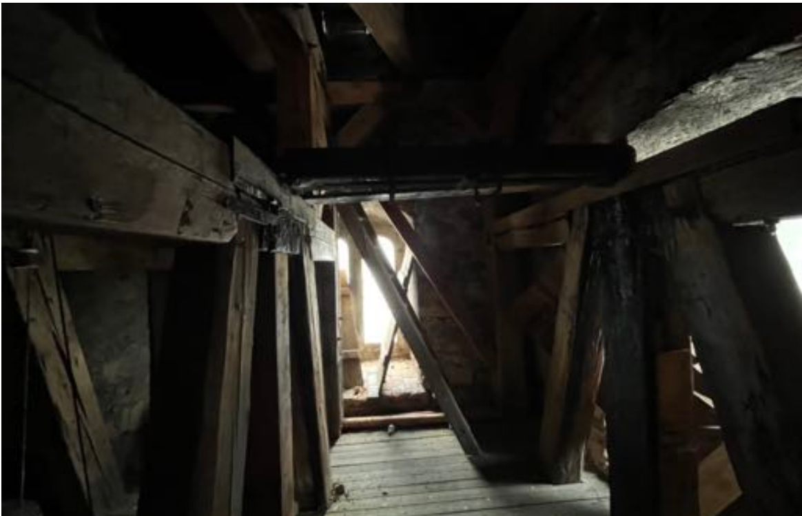
Fot. 66. Kościół pw. św. Jadwigi Śląskiej w Karpnikach. Wnętrze wieży, widoczna konstrukcja na poziomie górnych okien — biforium. Fot. Styczeń 2023 r.
