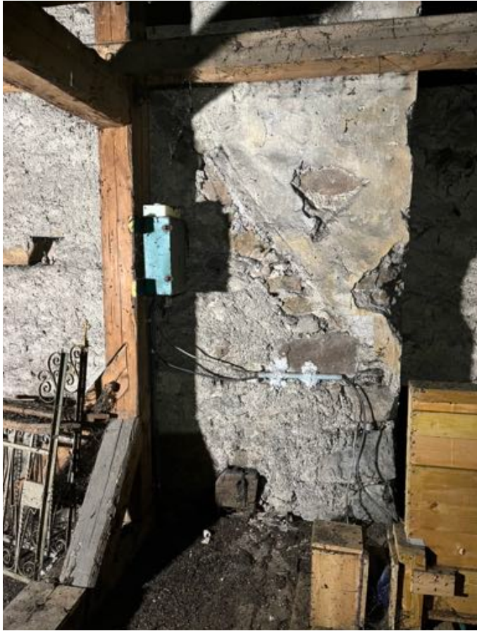
Fot. 29. Kościół pw. św. Jadwigi Śląskiej w Karpnikach. Poddasze nad nawą kościoła, ślady pierwotnego szczytu zachodniego na ścianie wschodniej wieży, widoczne pozostałości pierwotnej warstwy tynkarskiej i kolorystycznej elewacji wschodniej wieży oraz fragmenty kamiennego muru wieży. Fot. Styczeń 2023 r.
