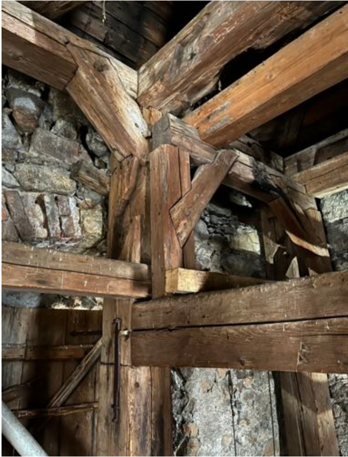
Fot. 65. Kościół pw. św. Jadwigi Śląskiej w Karpnikach. Wnętrze wieży, widoczna konstrukcja kamiennego mur, fragmenty wewnętrznej konstrukcji dzwonnicy z belek drewnianych. Fot. Styczeń 2023 r.
