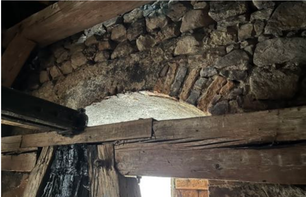
Fot. 61. Kościół pw. św. Jadwigi Śląskiej w Karpnikach. Wnętrze wieży, widoczna konstrukcja kamiennego mur, fragmenty wewnętrznej konstrukcji dzwonnicy z belek drewnianych oraz łuk otworu górnego okna — biforium. Fot. Styczeń 2023 r.
